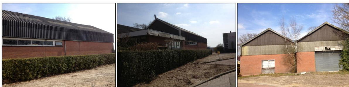
Afbeelding 2.3: Foto's bebouwing (Bron: Alfing Projects)
